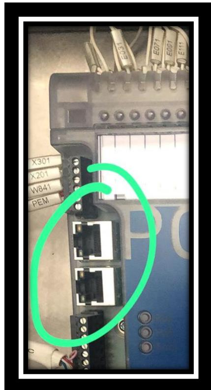
Conectar a la red el equipo. El puerto ethernet se encuentra en el tablero eléctrico. Los técnicos correspondiente deben asignar una IP fija en la red para el equipo a conectar. Esta IP debe ver la IP del servidor donde se encuentra nuestro software ya que nos vamos a enlazar mediante una sincronización FTP.
